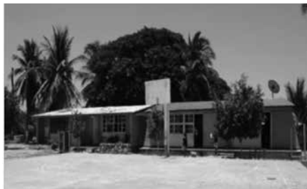
Construcción anterior a los daños de los huracanes del 2013.
